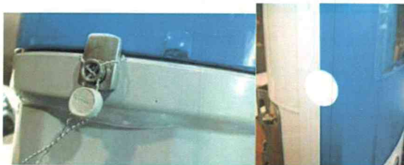
Рисунок 5 – Защита преобразователей сигналов IFC300 C/F/W и клеммной коробки ППР от вскрытия
